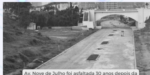
Av. Nove de Julho foi asfaltada 30 anos depois da avenida Paulista. Acervo/Estadão
